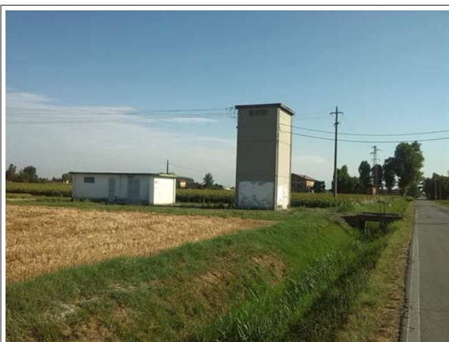
Illustrazione 11: Cabine di trasformazione MT\BT
