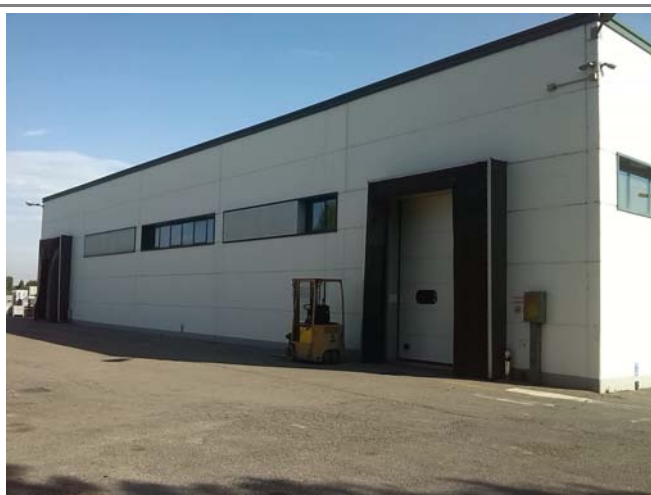
Illustrazione 14: Baie di carico\scarico lato sud
