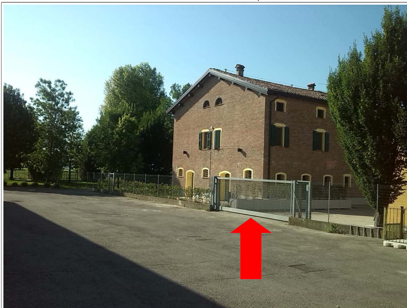
Illustrazione 3: Cancello carrabile di collegamento tra edificio residenziale e area carico e scarico merci lato sud ditta Antica Foma.
