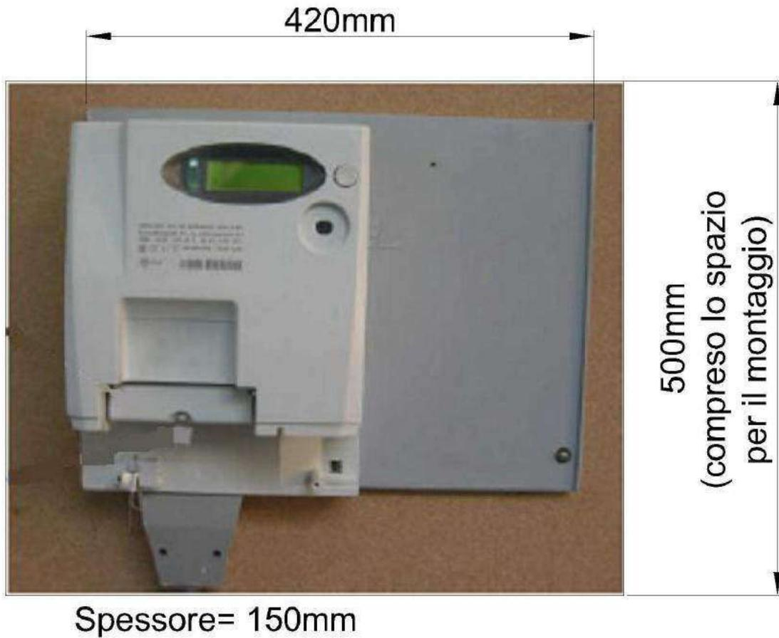
b) Installazione GET3A all'esterno con posa su nicchia a muro predisposta dal cliente per alloggiamento contenitore unificato Enel DS 4559 o spertello di chiusura (per la posa del complesso di misura tipo GIST vedi modalità illustrata per le forniture fino a 16,5 kW).
