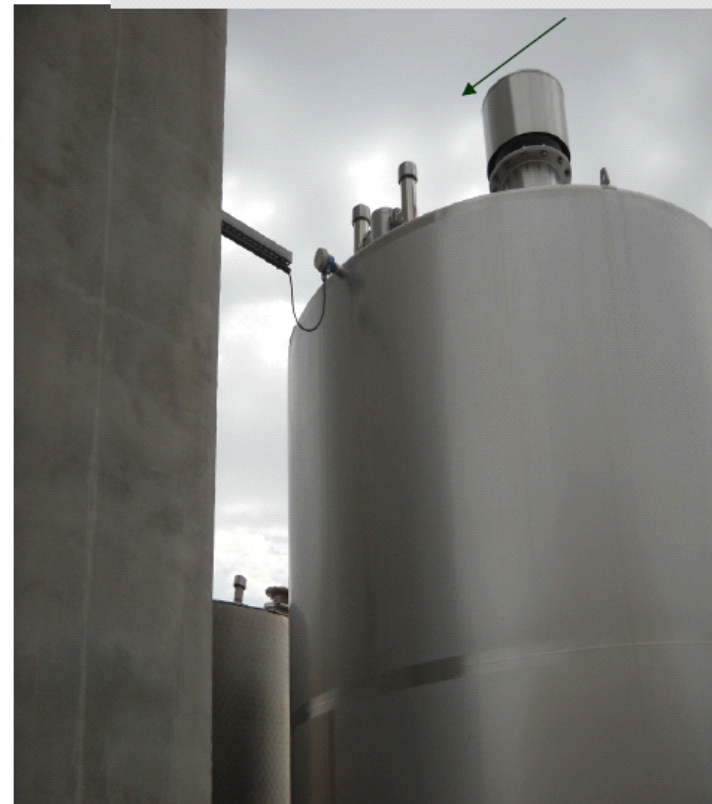
Filtro a carboni attivi posto su silos di stoccaggio sangue
