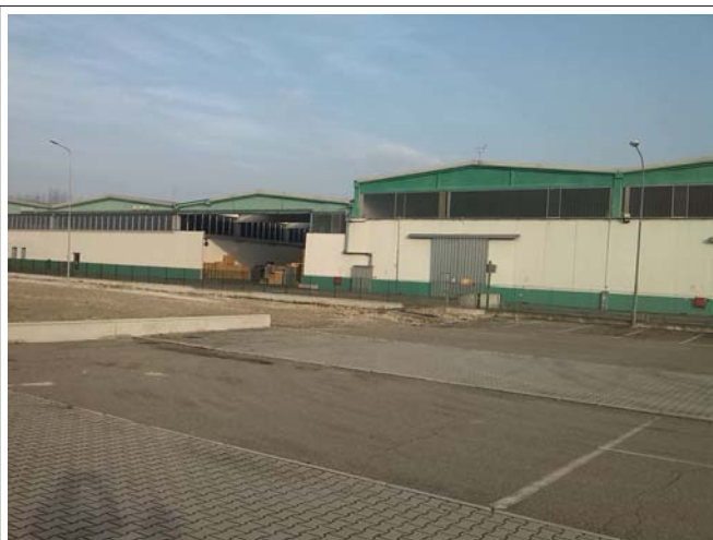
Illustrazione 2: Edifici 1-12-14 lotto A
