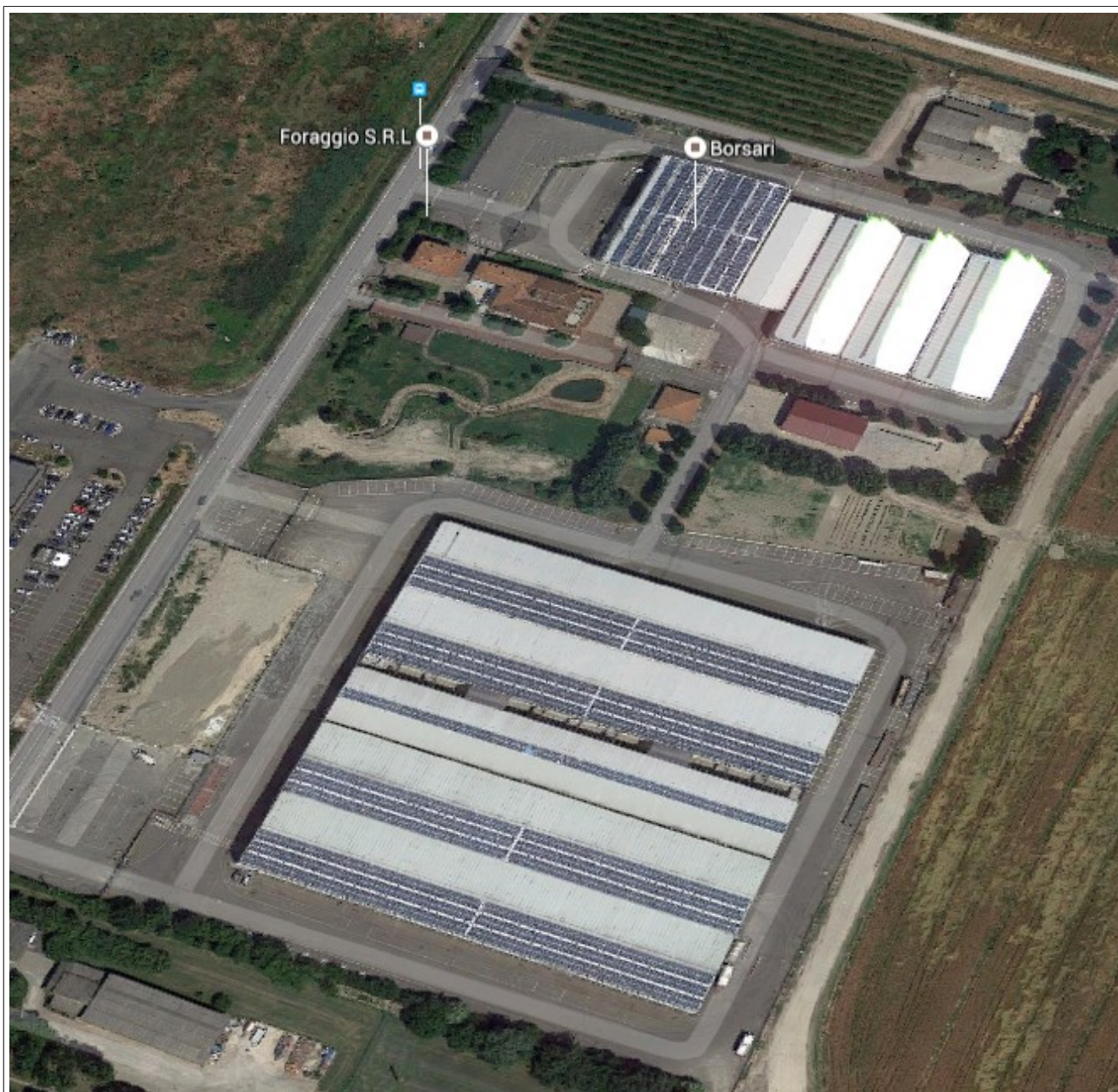
Illustrazione 3: Pannelli solari esistenti
