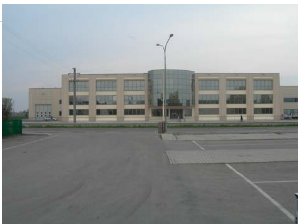
Illustrazione 4 - attività produttiva sul fronte opposto di via di mezzo
