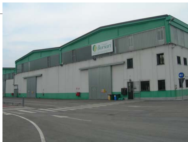
Illustrazione 5 - Fabbricati esistenti
